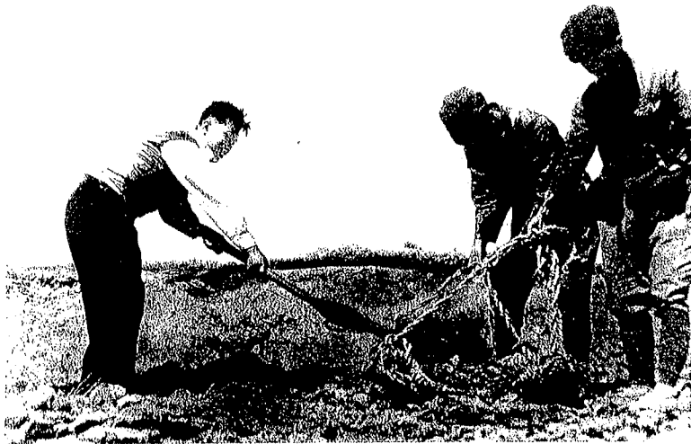
보통강개수공사의 첫삽을 뜨시는 경애하는 김일성주석님(1946.5.21)
